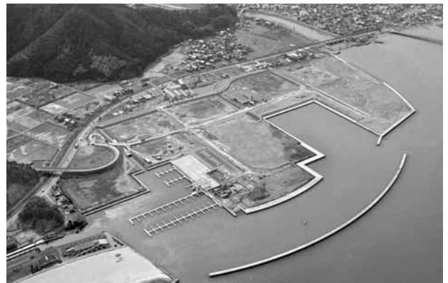
マリンワールド施工状況
