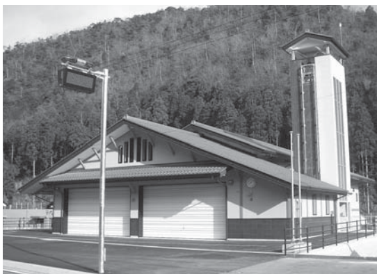
完成した若狭消防署名田庄分署
