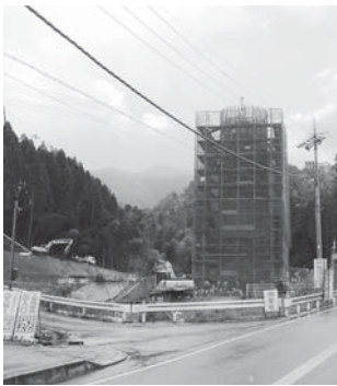
工事が進む坂本高浜線
