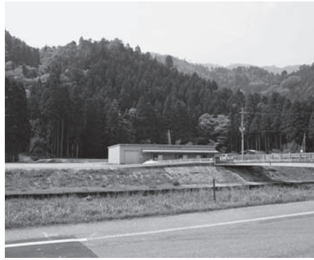
造成が進む林産加工施設用地
