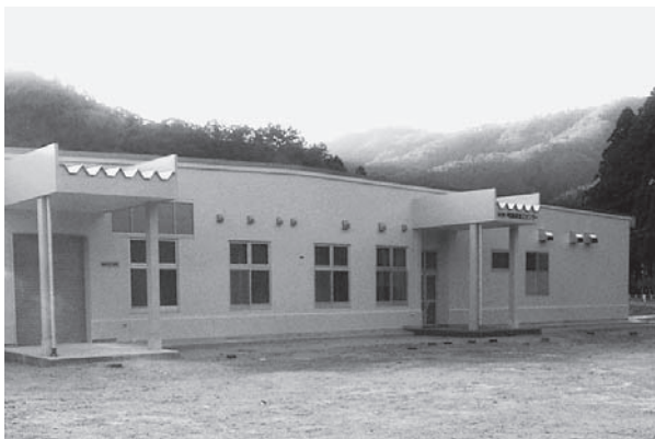
4月に供用開始される予定の農産加工施設
