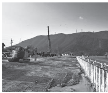
浸水被害改善施設整備工事の様子
