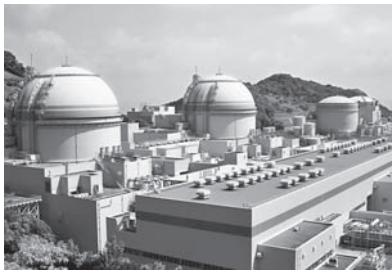
関西電力 大飯発電所
