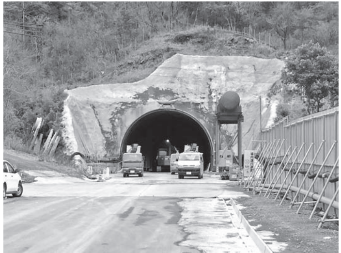
工事が進む(仮称)新大島トンネル(犬見側)
