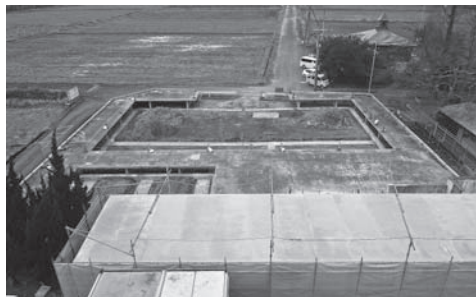
改修工事が進む名田庄 中学校プール
