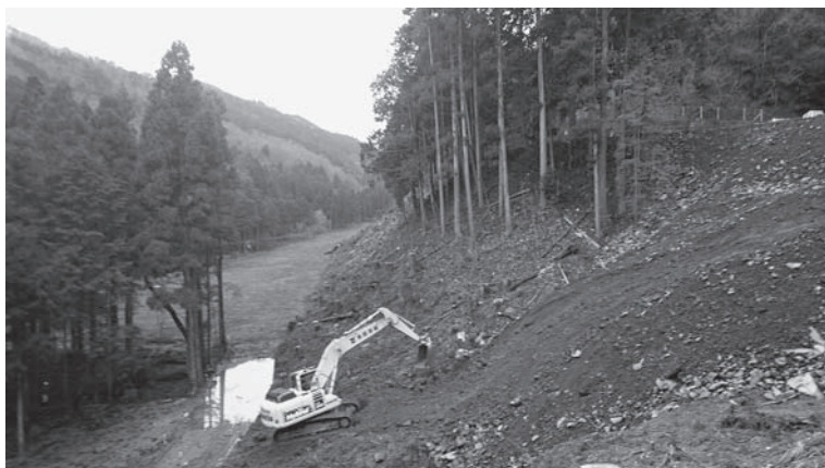
改良工事が進む県道小浜綾部線（川上地係）
