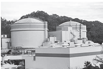
廃炉が決まった大飯発電所1・2号機
