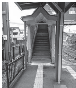
本郷駅敦賀方面ホーム跨線橋
