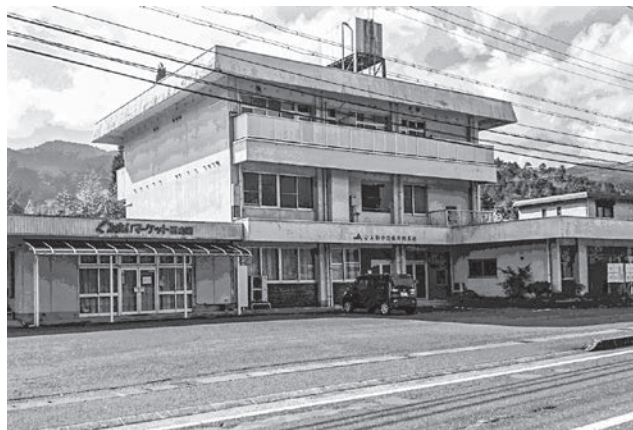
解体撤去される職員宿舎など
