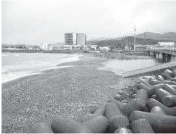
佐分利川河口の堆積土砂の状況
