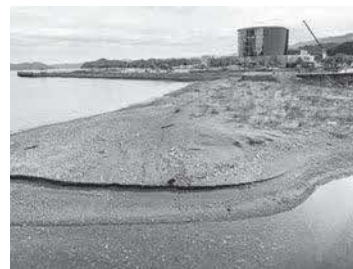
除去された堆積土砂の状況
