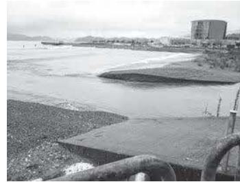
堆積土砂を除去後の佐分利川河口
