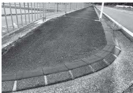
除草後の県道の歩道
