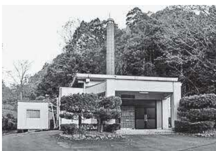
老朽化した小浜市の斎場
