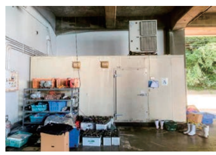
既存のプレハブ冷凍庫
