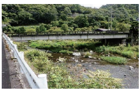
柵橋側面上流側より
