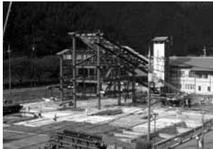
名田庄総合施設順調に建設中
