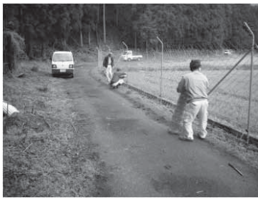
(獣害防止柵の維持補修)
