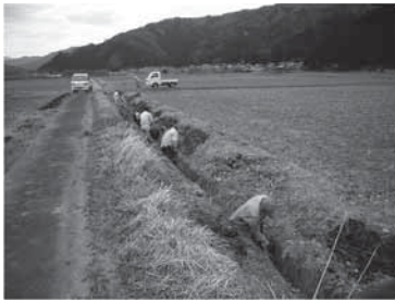
(水路の泥上げ)
