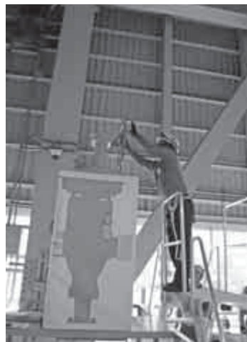
③主蒸気逃がし弁手動開放訓練
