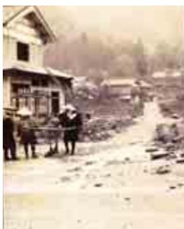
台風13号時の被害写真
