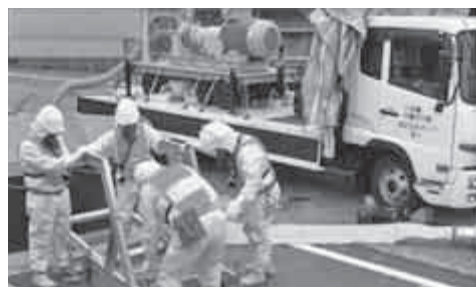
代替設備設置訓練 (可搬式代替低圧注水ポンプ)
