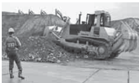
がれき撤去訓練
