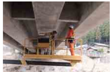
近接目視による点検 (町道子生谷線 左近前橋)
