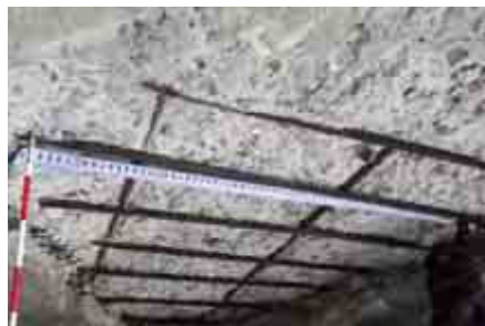
コンクリート橋の損傷状況 (国道27号 中津海橋)
