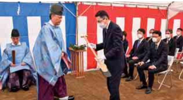
「山村JR貨物きらベジステーション」の野菜工場建設にあたり地鎮祭が行われました。当日は、社長の木村周二さんが穿初 うがらぞめ の儀を行い、工事の安全を祈願しました。工場は来春の稼働を予定しております。(3月30日(水) 尾内区)
